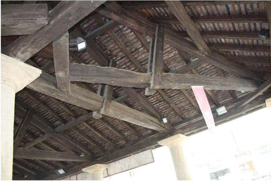
Ferme d'arétier (portant sur les colonnes en diagonale E2 et F1)
