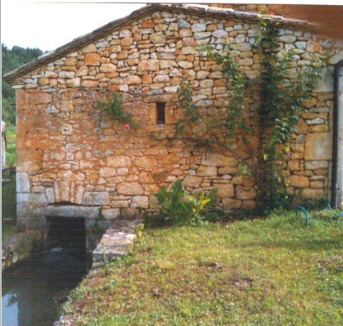
Exutoire au sud-ouest
