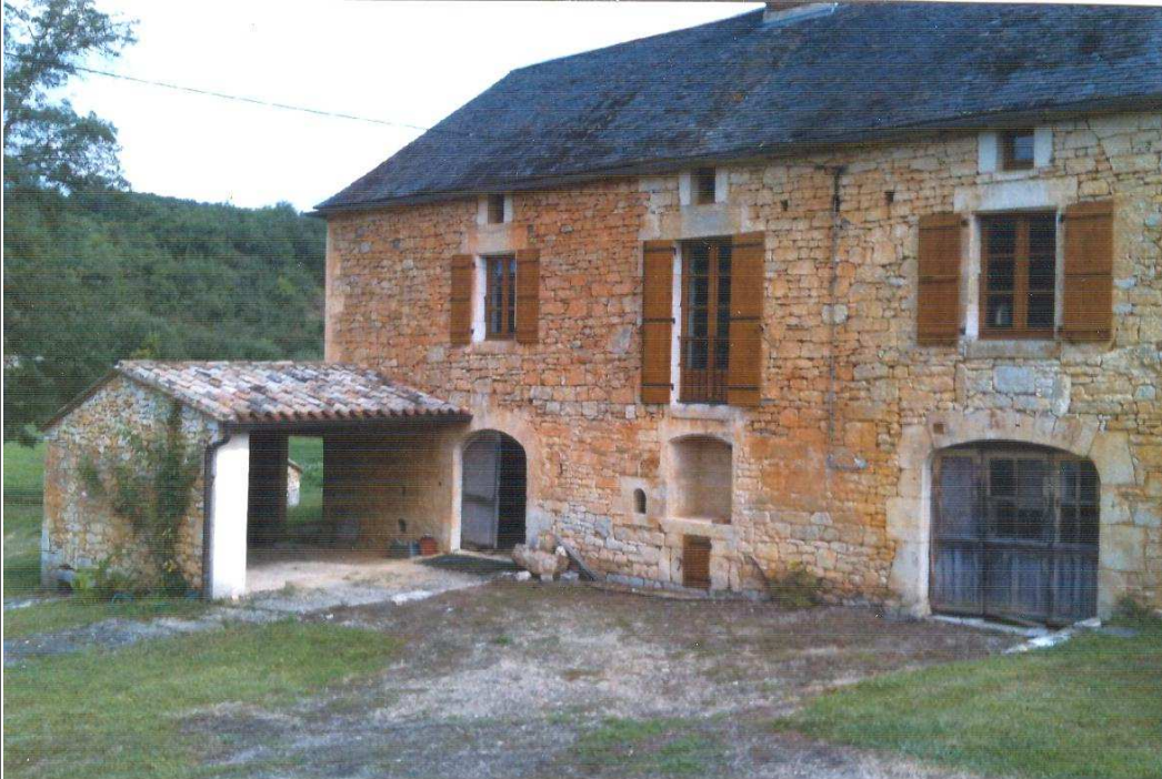
Façade sud-ouest A gauche, en rez-de-chaussée, l'entrée du moulin. A droite, ancienne boulangerie au rez-de-chaussée, logement du meunier à l'étage
