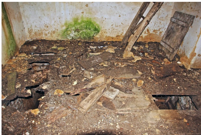
Plancher du palier intermédiaire avec échelle d'accès au pigeonnier
