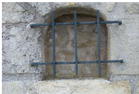
La niche de la façade avant
