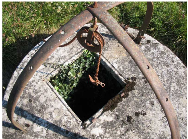
Détail de la poulie et du crochet
