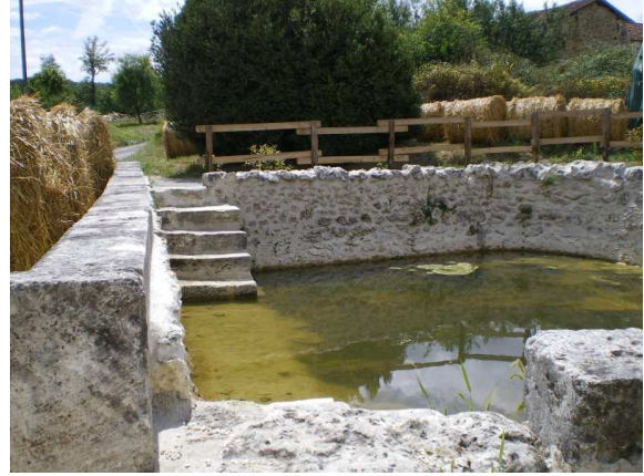
L'escalier, côté route d'accès et puits
