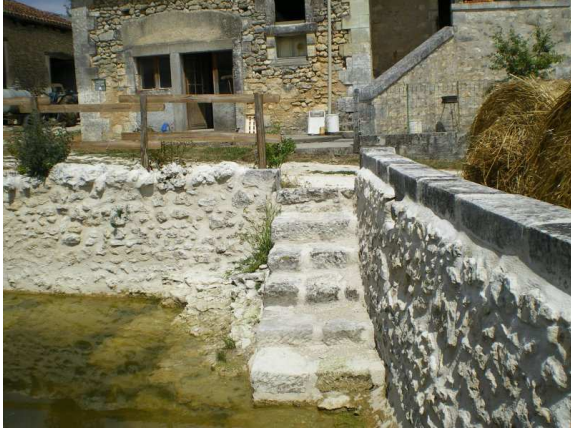
L'escalier, côté maison Groumillet
