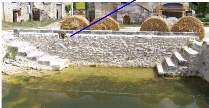
Les deux escaliers
