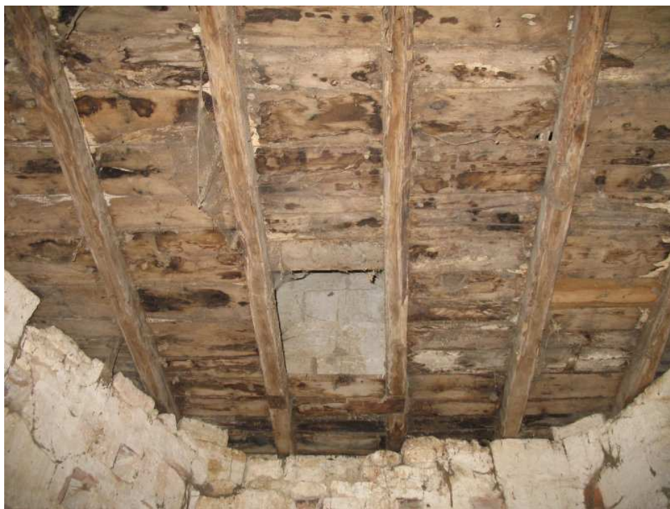
Le plafond et la trappe d'accès au 2 e étage
