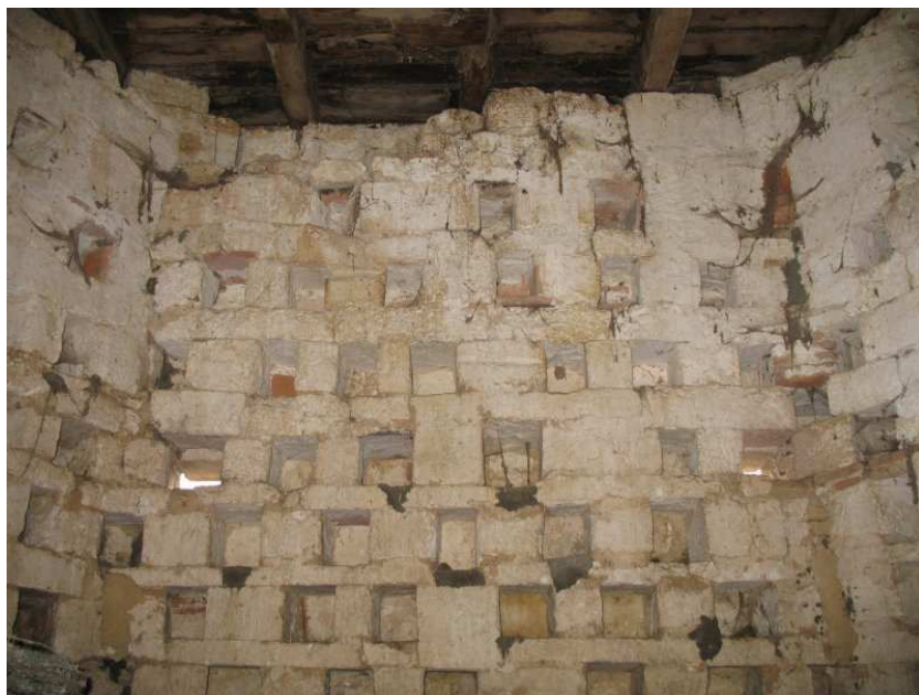
Les boulins A gauche, ceux du mur opposé à la porte Ci-dessus, détail
