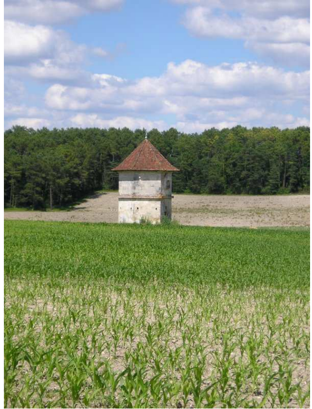
Vue depuis la route
