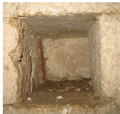
Les boulins A gauche, ceux du mur opposé à la porte Ci-dessus, détail
