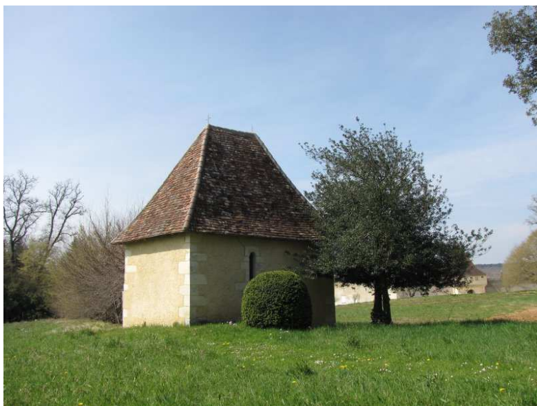
Vue depuis le chemin (arrière et côté)
