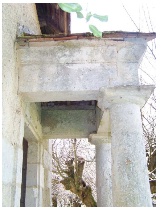
Le portique d'entrée, vu de côté
