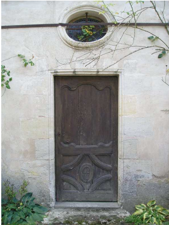
La porte d'entrée (façade est)
