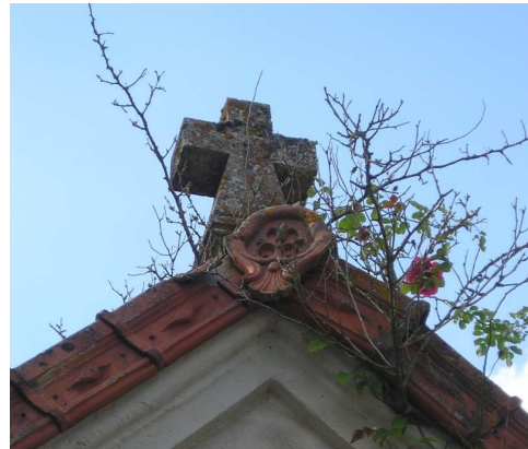
Détail du sommet du pignon
