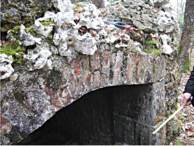
Le linteau en briques et les pierres d'ornement au-dessus
