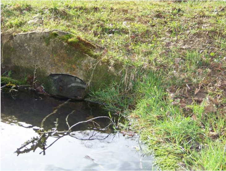
Le déversoir du lavoir sous le chemin
