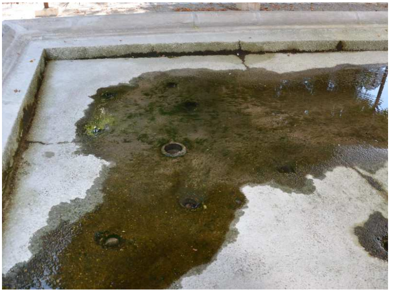
L'alimentation en eau du lavoir : À gauche : l'arrivée de l'eau de la fontaine À droite : les sources au fond du lavoir
