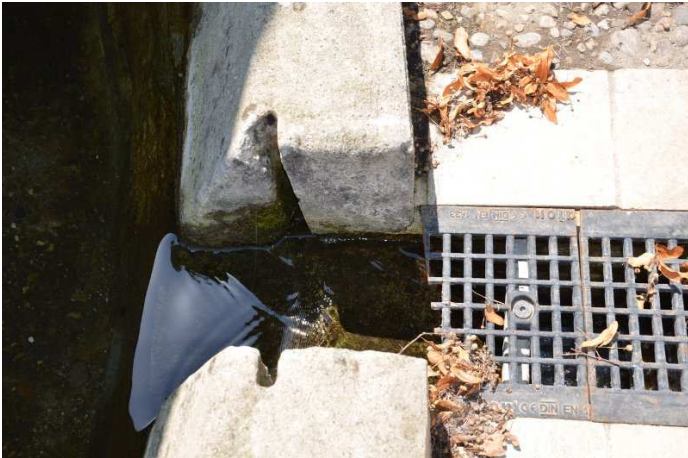
Le déversoir du lavoir
