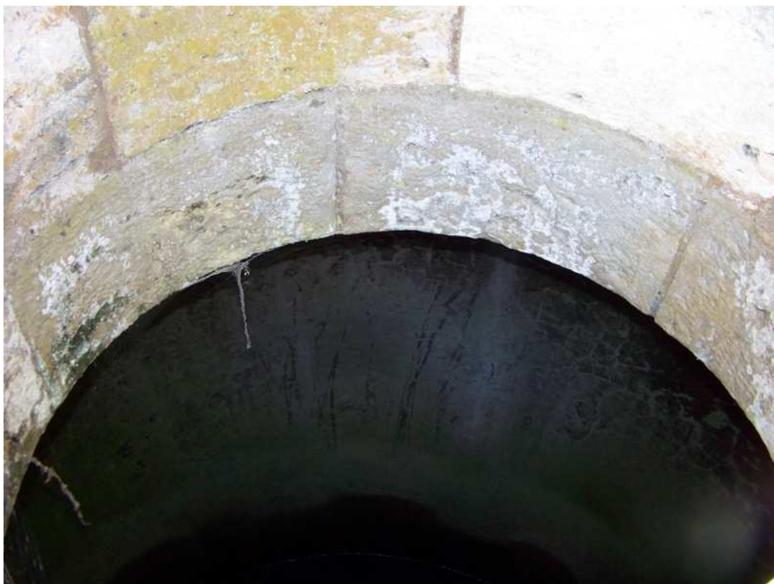
L'intérieur du puits
