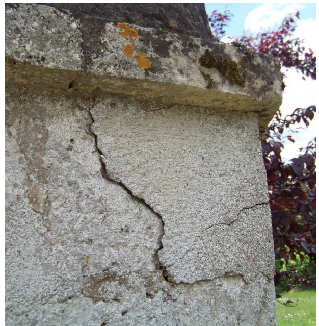
Détail de la corniche sous la coupole
