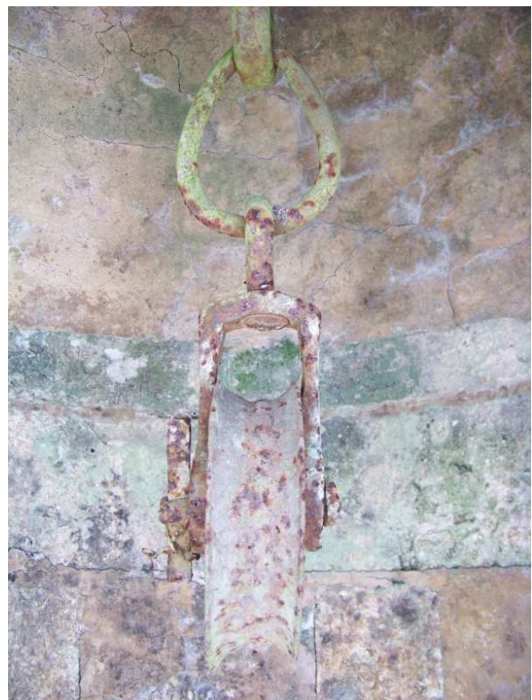
La poulie et le revêtement intérieur
