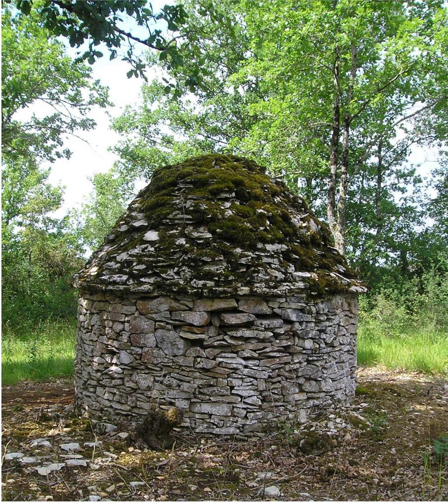
Vue de l'arrière de la cabane et détail du début de la dégradation du toit causée par les intempéries et les mousses sur le côté exposé au nord.
