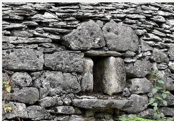
« Fenestrou » côté Sud Ouest
