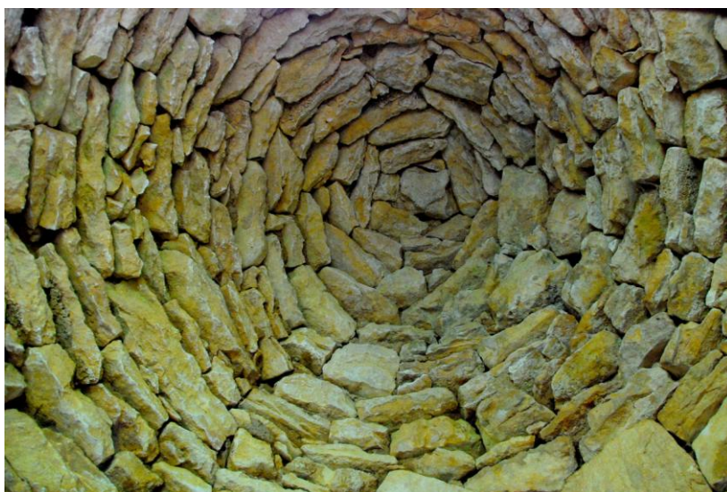
Vue de la voûte intérieure (intrados) juillet 2011
