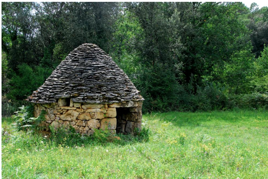
Façade Sud Est juillet 2011
