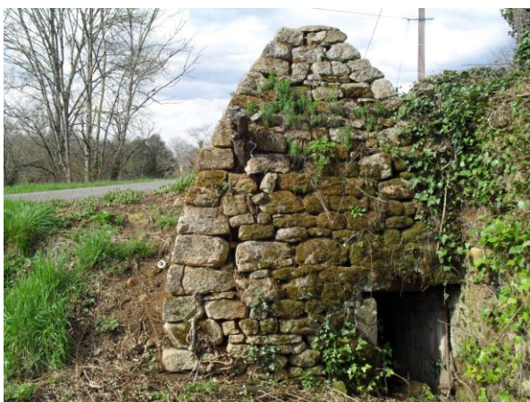
Vue côté sud
