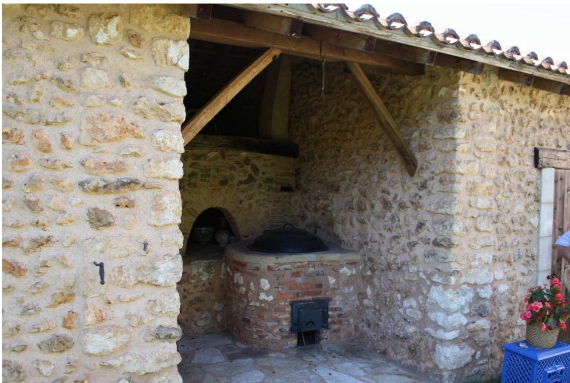
Fournil avec fourneau et chaudière
