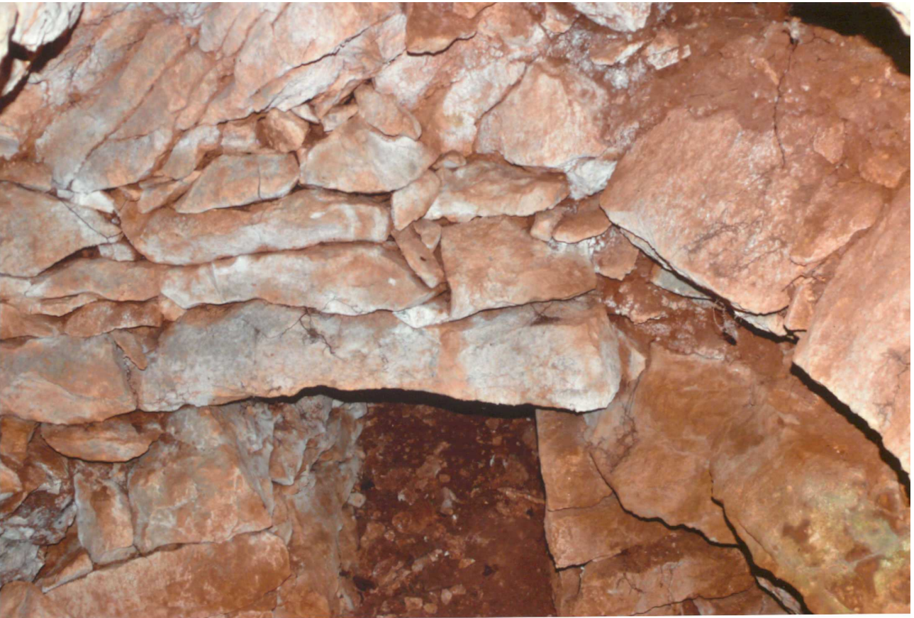
Linteau et voûte au départ de la galerie basse
