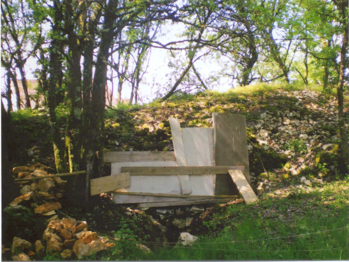
Site du cluzeau : au-dessous des protections anti-éboulement, l'excavation d'accès
