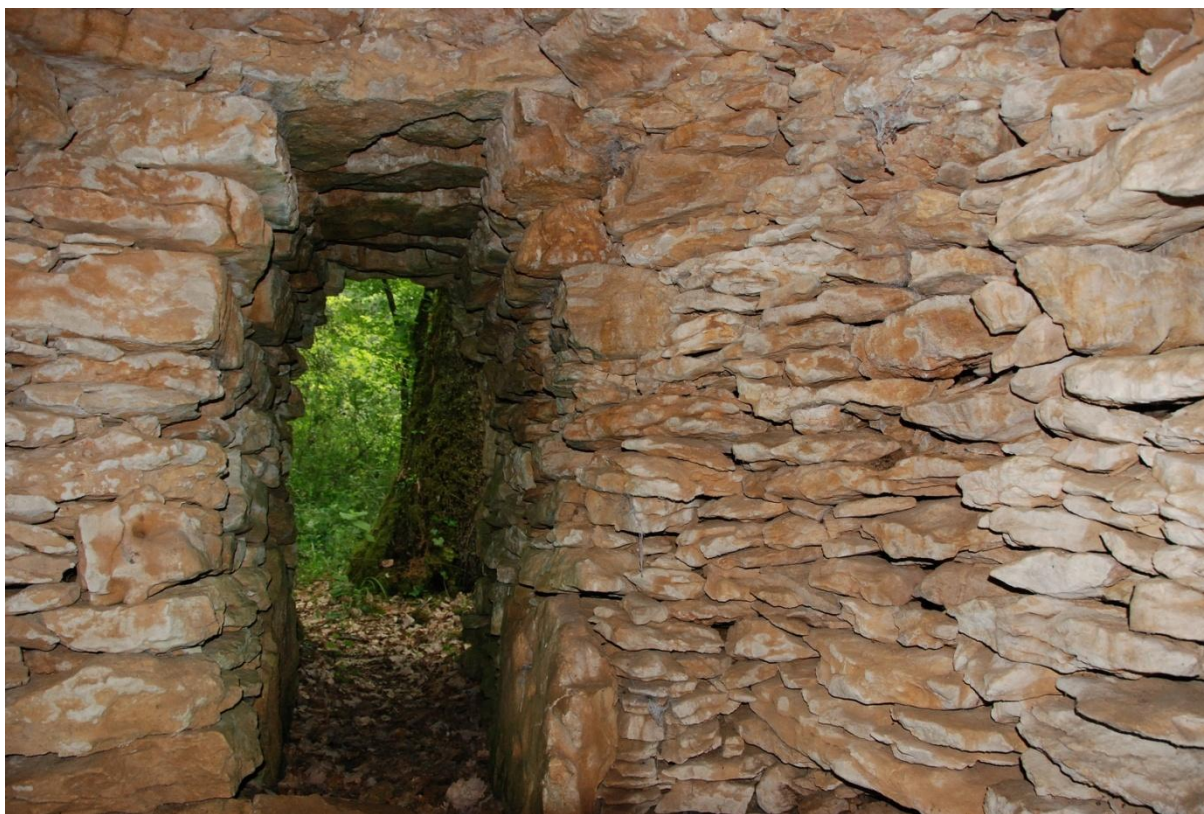
Vue intérieure du « couloir » d'accès
