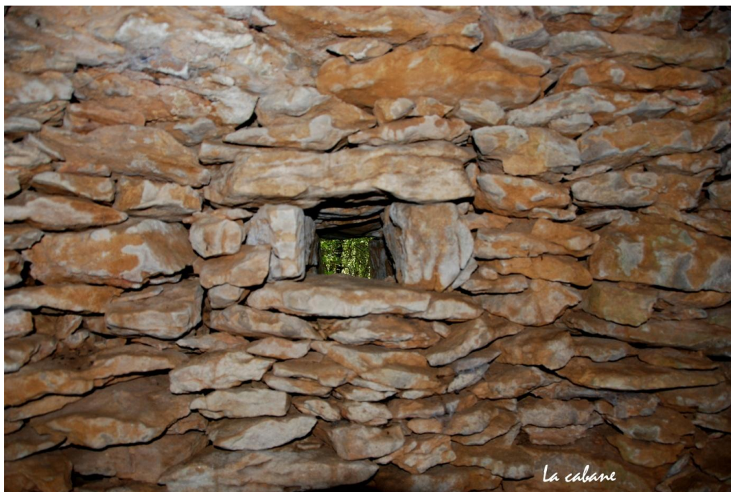
Un regard de 20 x 20 a été construit dans le mur Ouest
