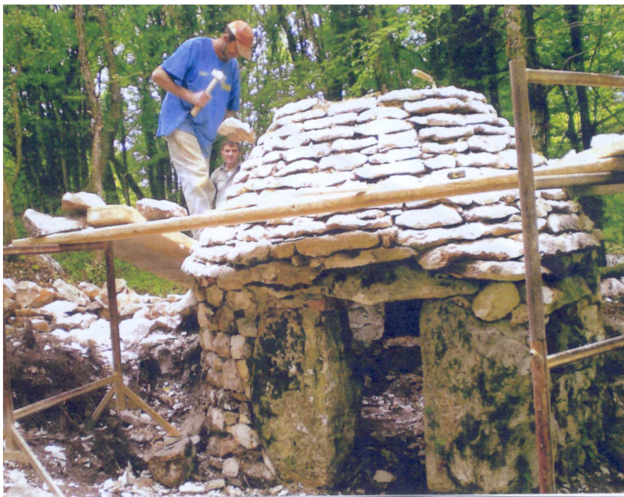
Chantier en juillet 2011
