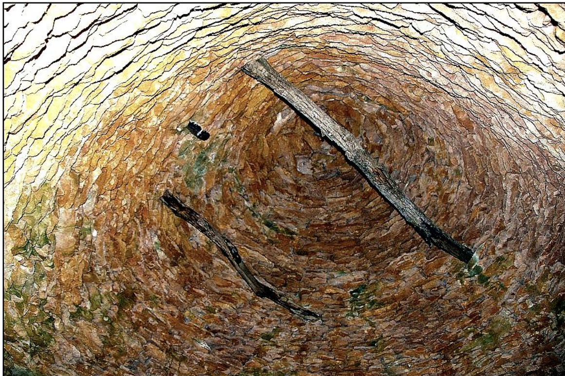
Intrados de la voûte en encorbellement
