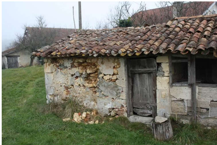
Partie contenant les chaudières
