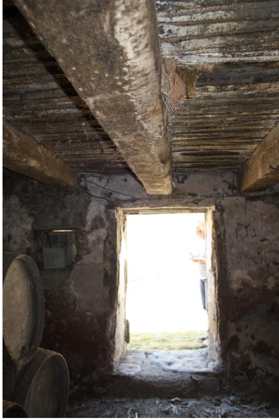
Niveau inférieur vu en direction du nord
