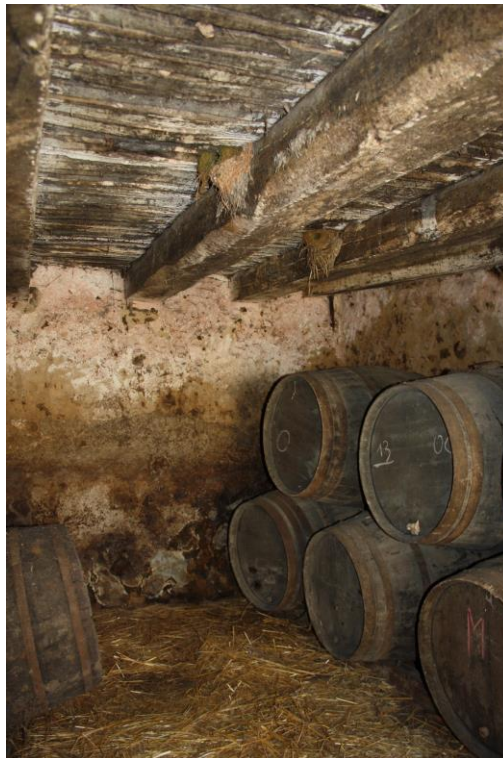
Niveau inférieur avec nouvelle fonction
