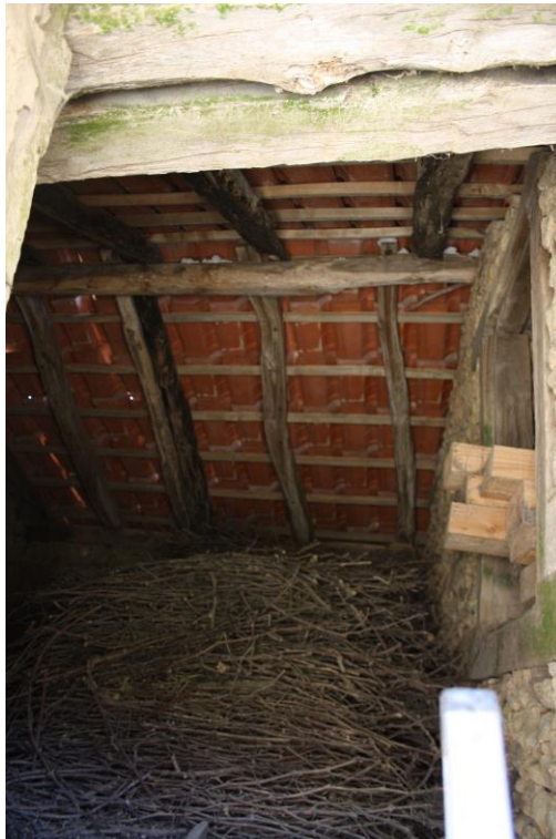
Niveau supérieur vu depuis la baie d'accès A droite, accès au comble du local mitoyen
