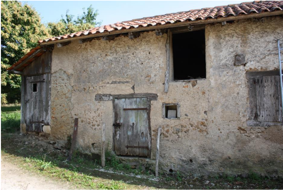
Façade principale avec porte d'entrée et accès à l'étage
