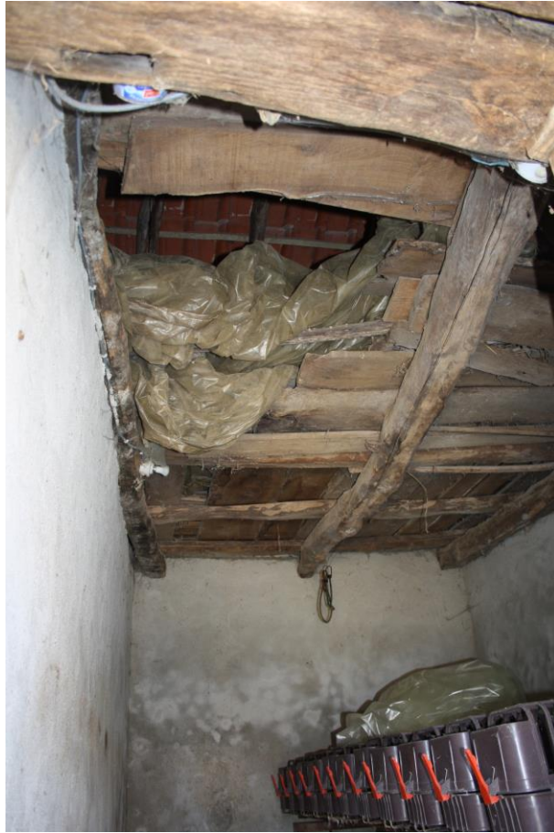
Accès à l'étage du clédier par le comble de la salle de gavage
