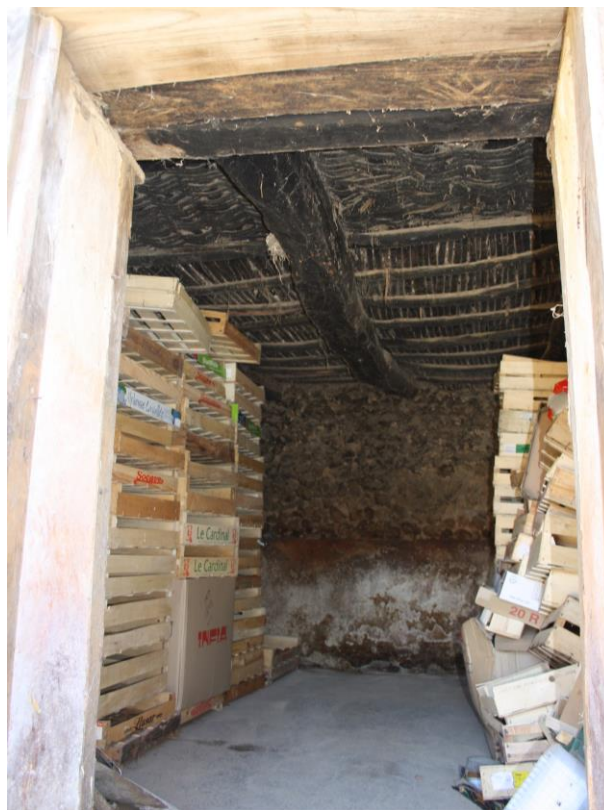
Vue intérieure depuis la porte d'entrée
