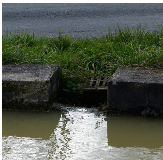
Déversoir d'évacuation de l'eau
