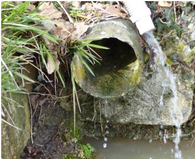
Le déversoir d'alimentation
