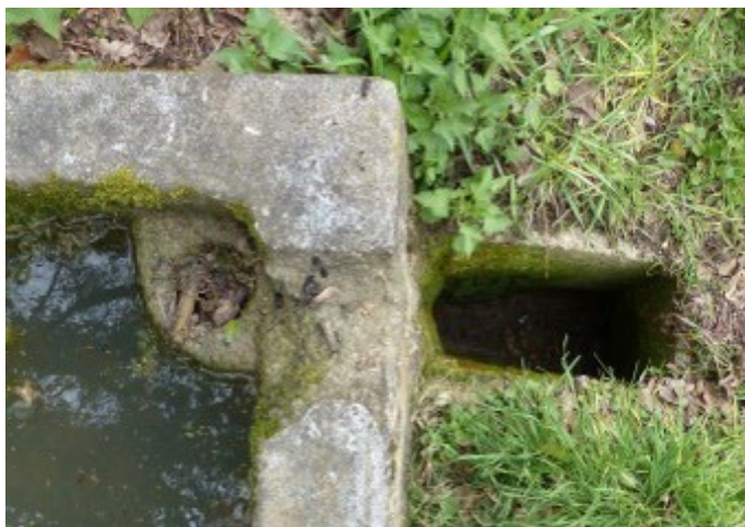
Le trop plein et l'évacuation vers le lavoir
