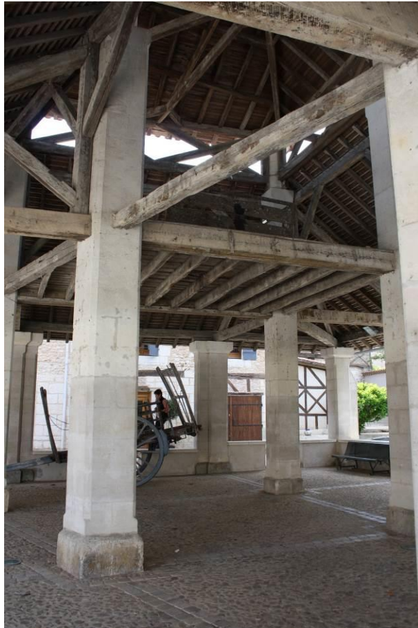
Solivage du plancher et murette ouest (la murette nord est cachée par le banc) Au premier plan, travée C
