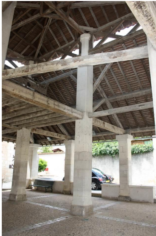
Vue intérieure avec, au centre, le pilier C3
