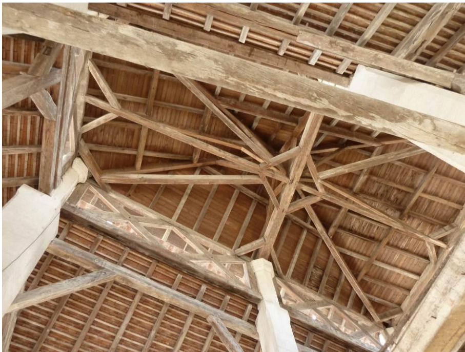
Charpente du lanterneau avec son enrayure
