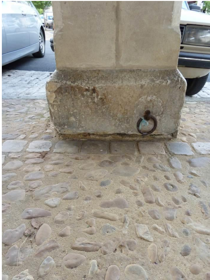
Pilier E2, calade et alignement de pavés
