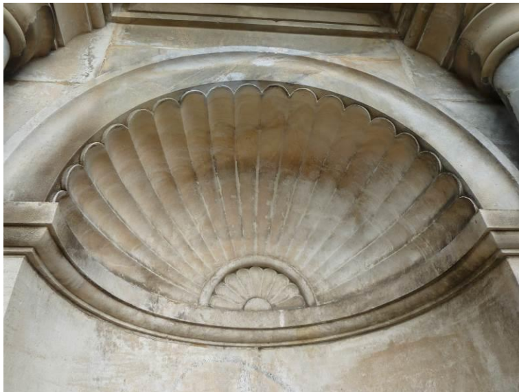
Cul de four de la façade principale
