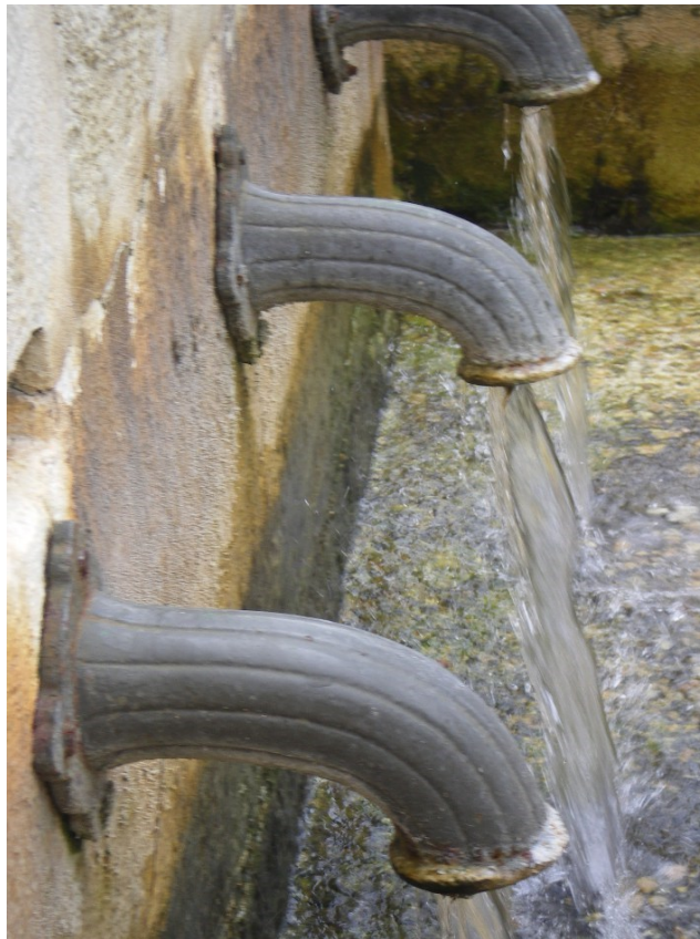
Détail des bouches à eau
