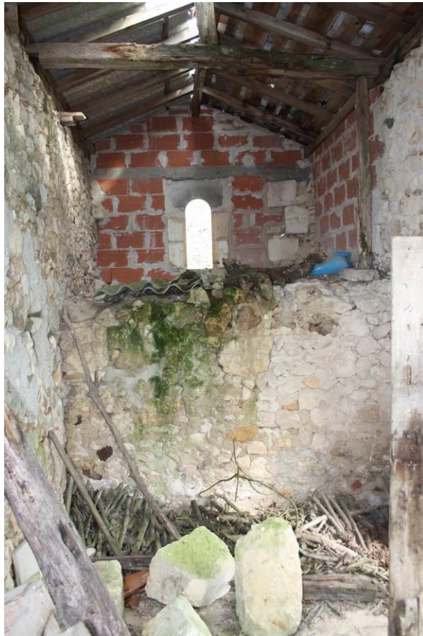
Vue intérieure vers l'est
