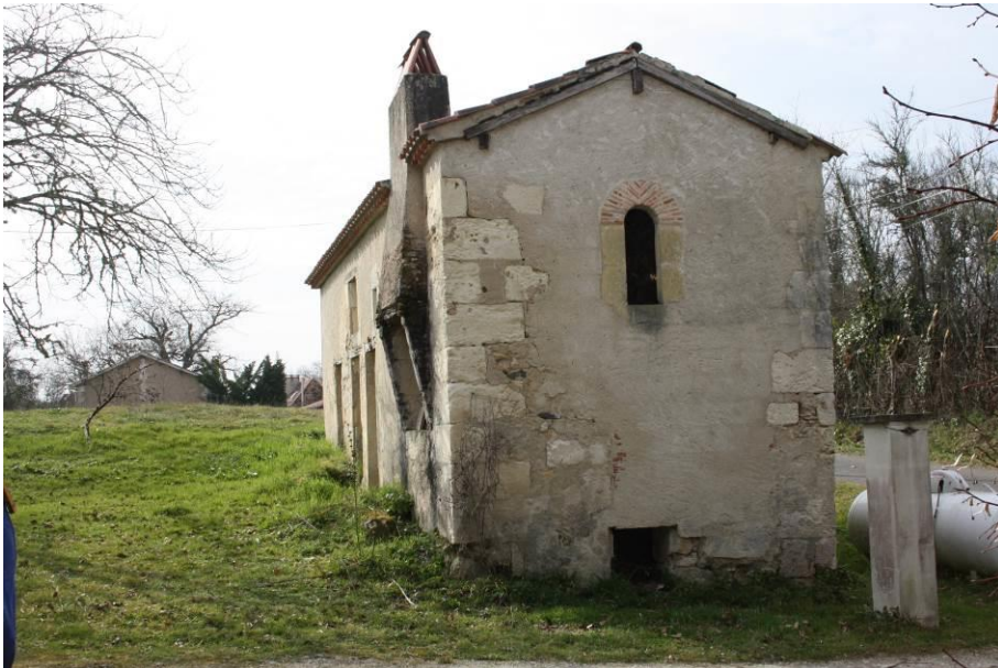
Pignon est avec accès au sous-sol
