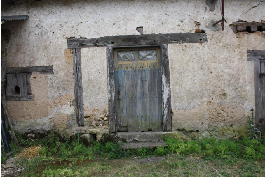
Façade du fournil
