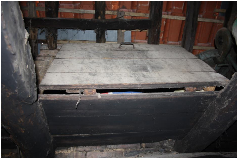
Trappe d'accès au comble
