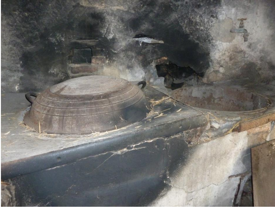
Chaudière gauche fermée
