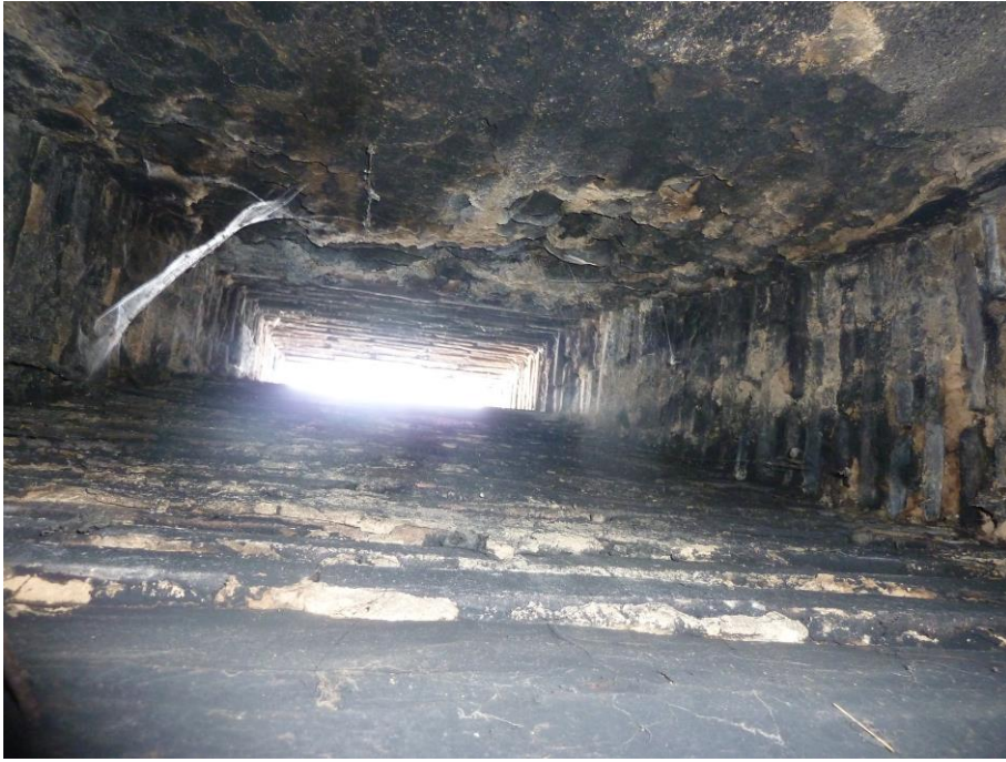
Cheminée du four
