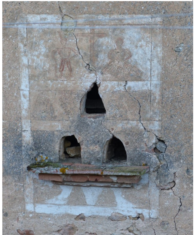
Fuies du pignon
