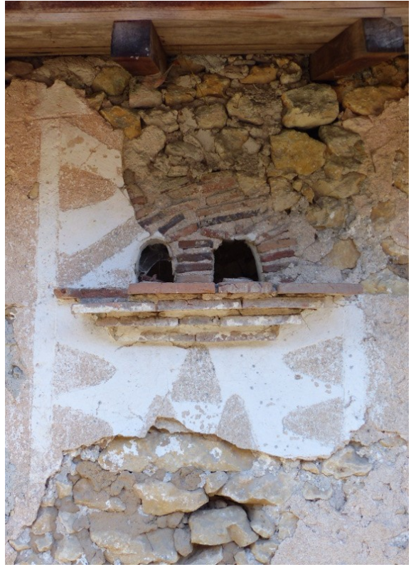
Fuies sur le mur de côté
