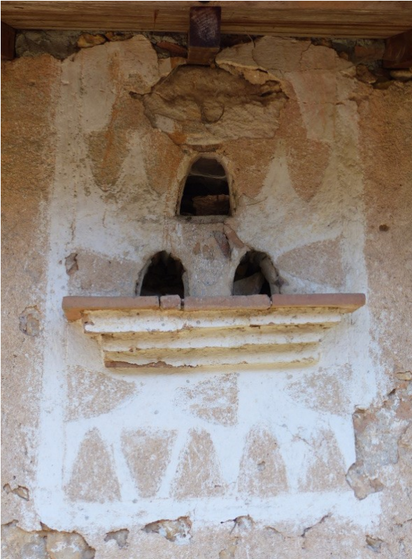
Fuies sur le mur de côté
