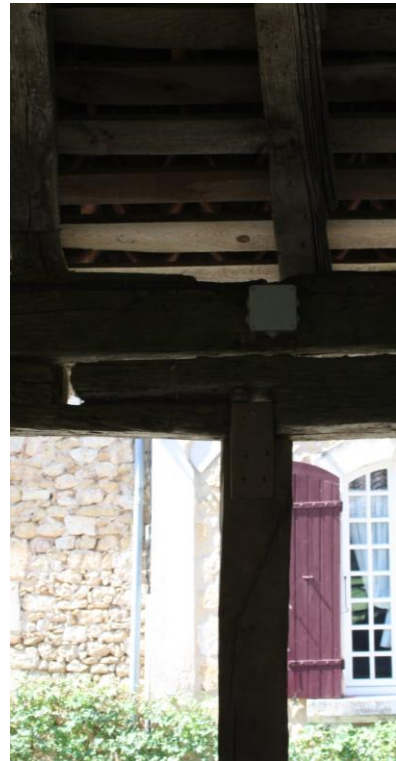
Soutien provisoire de la sablière entre C1 et D1
