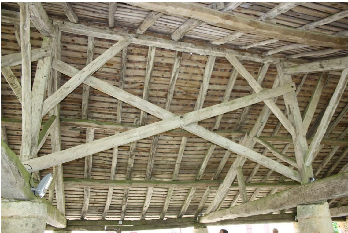
Contreventement entre les travées C et D (croix de Saint André)
