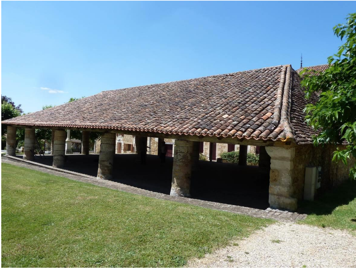
Couverture (long pan sud, croupe est avec double arêtier)
