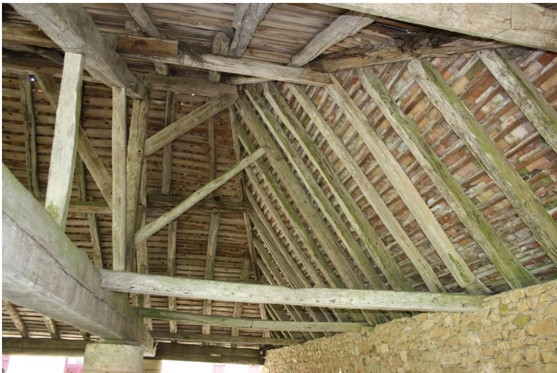
Charpente côté est (travées E et F) : demi-ferme de croupe
