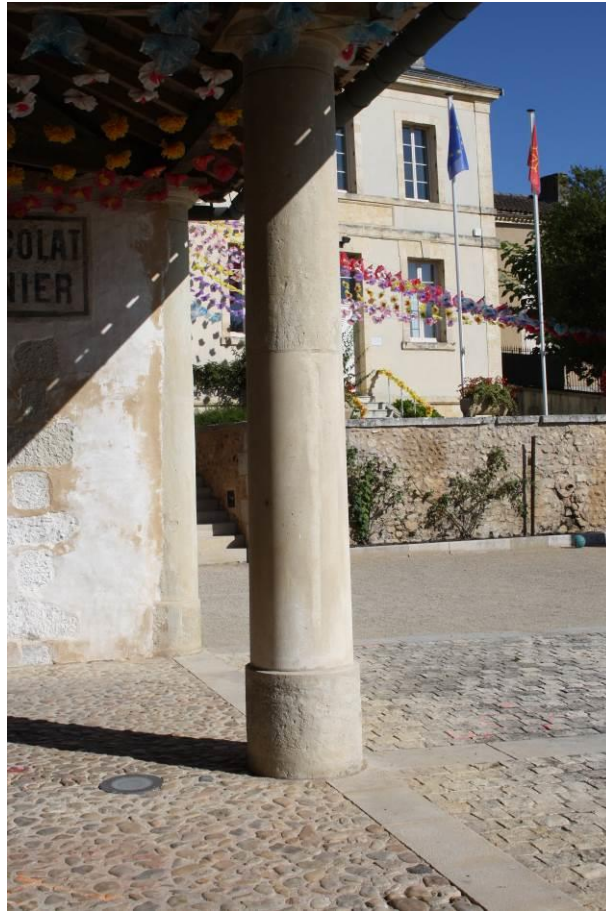
Colonne B3 et sol en calade de galets avec éclairage intégré
