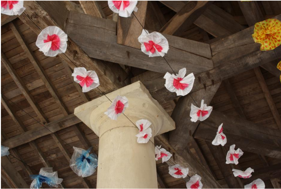
Colonne B2 et enrayure pour les demi-fermes d'arêtier
