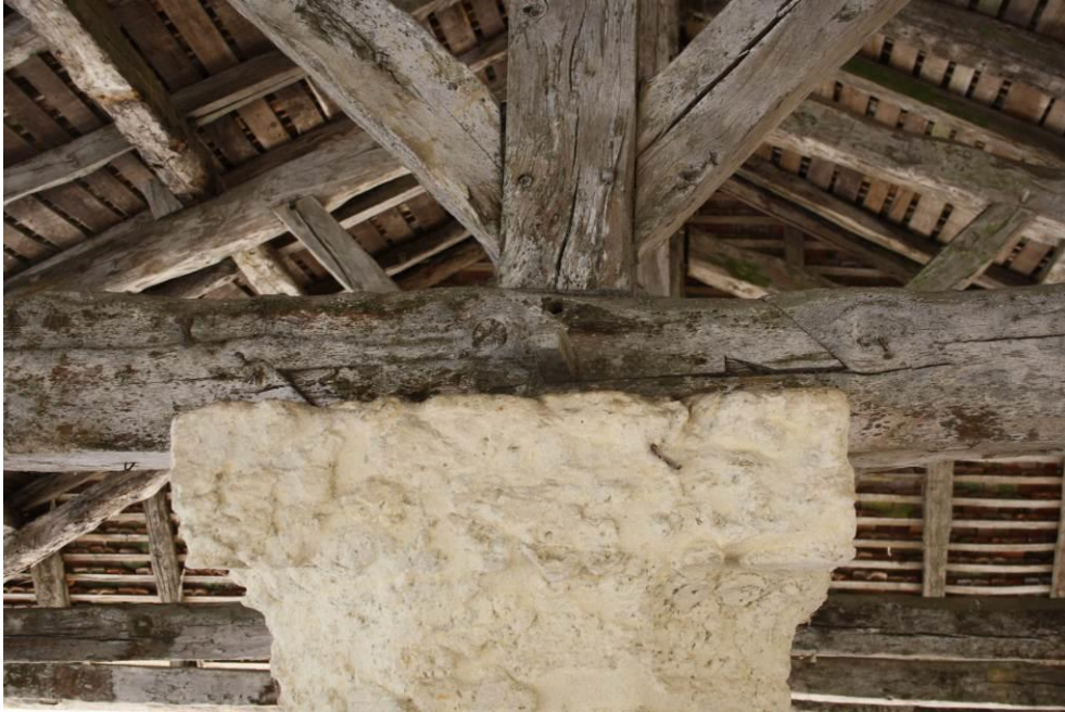
Entrait en deux éléments reliés par un trait de Jupiter et sa clavette de serrage
