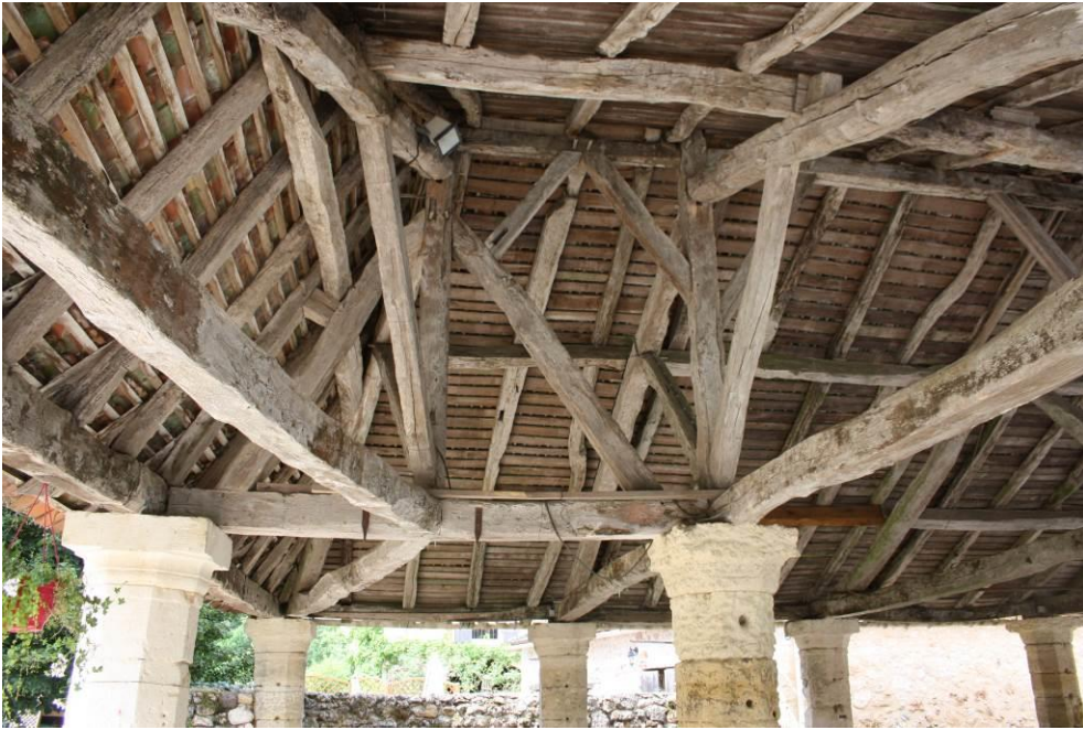
Travées A et B avec demi-fermes de croupe et d'arêtier
