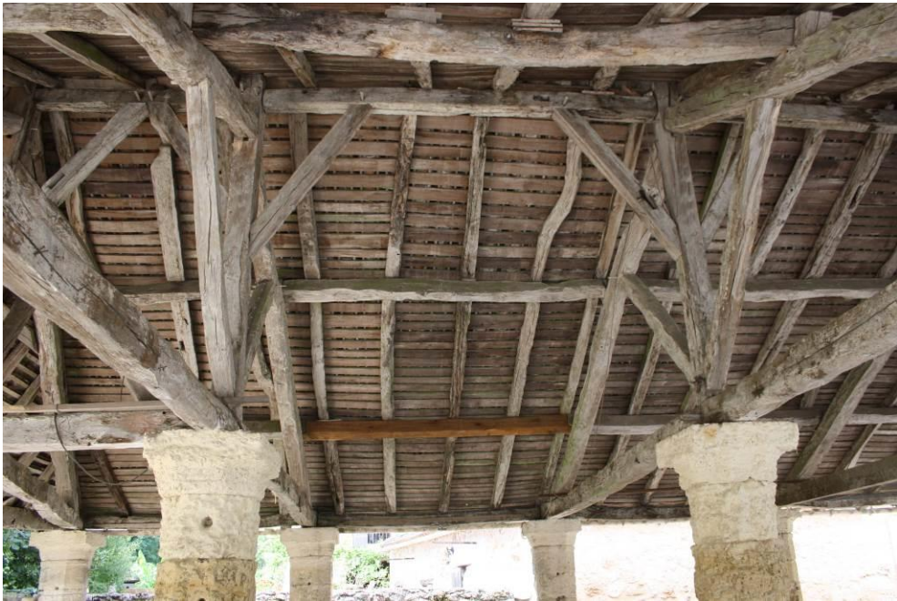
Fermes B et C, au premier plan, piliers de la travée 2, en arrière, panne neuve
