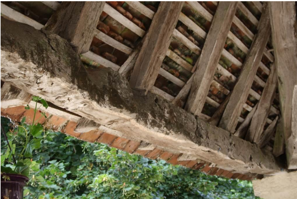
Croupe ouest avec emboitement des chevrons, coyaux et liteaux
