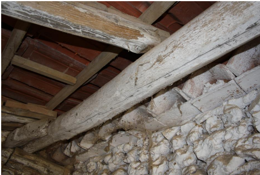
Mur extérieur de l'étable sur lequel est bâti le poulailler (reconnaissable à la présence de la génoise)
