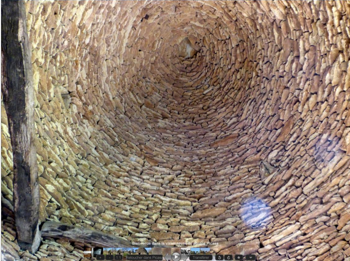
Intrados de la voûte en encorbellement
