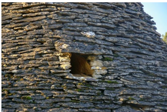
Ventilation de toiture au dessus de la "meurtrière"
