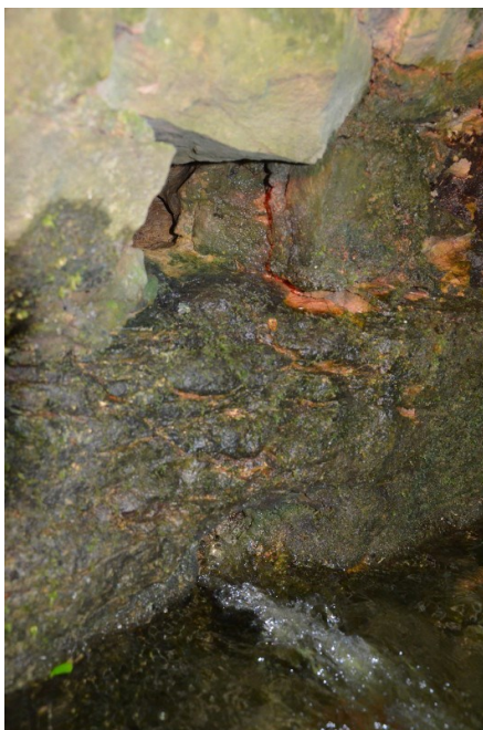
L'intérieur par temps sec A gauche la sortie de l'eau par orifice sous la niche
