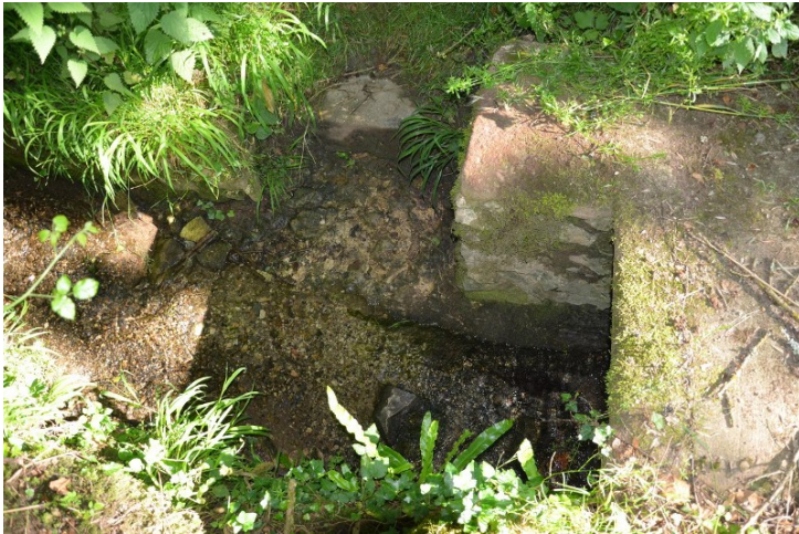
Vue côté sud ouest (accès à la fontaine)
