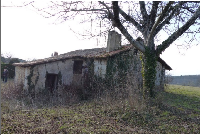
Façade arrière (nord-ouest)
