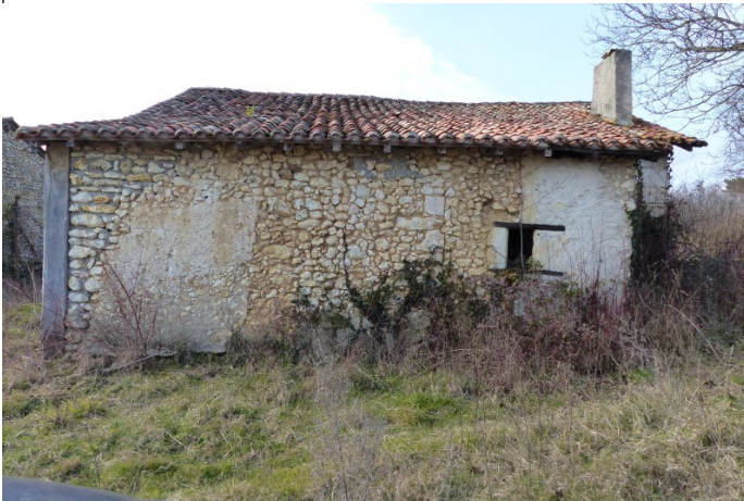
Façade latérale (est)
