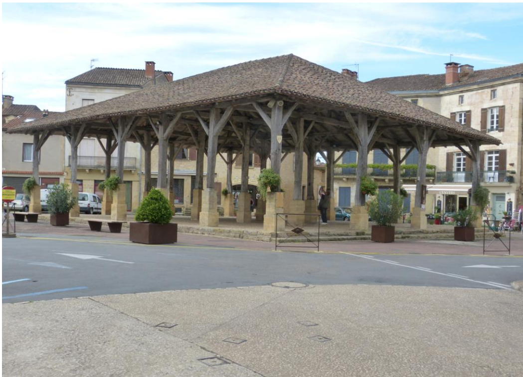
Vue du coté sud-est
