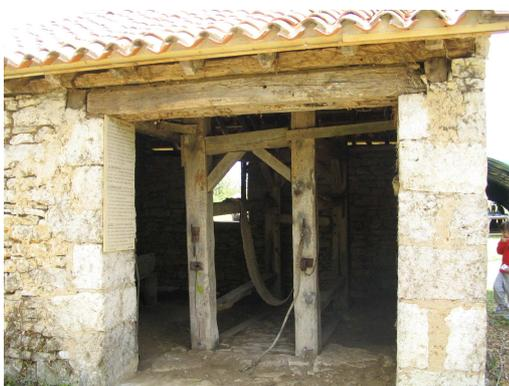
angle ainsi formé par une pièce verticale et une pièce horizontale est renforcé par l'assemblage d'un gousset
